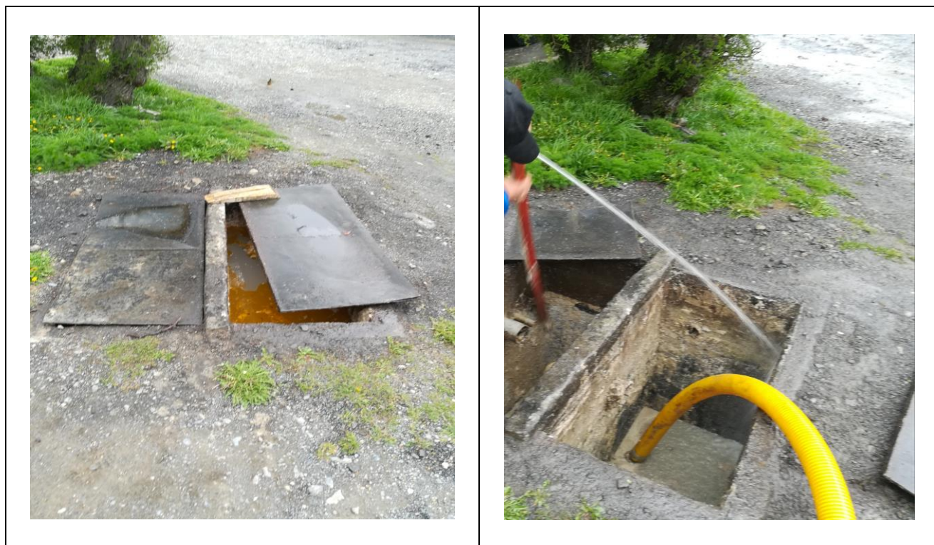
Figura 1. Chequeo y mantención de cámara desgrasadora
